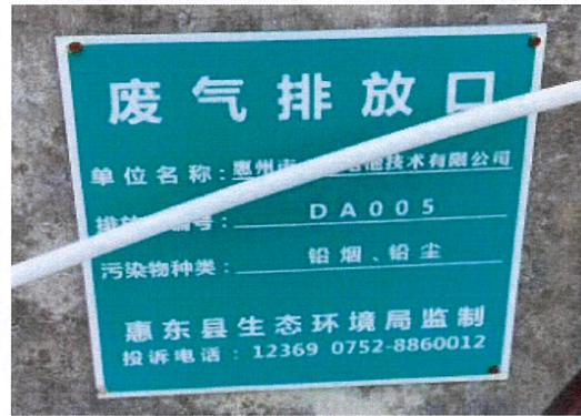
有组织废气处理监测口 (DA005) 标识牌
