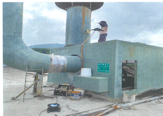
有组织废气处理后监测口 (DA004)
